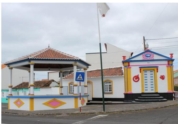
PINTURA de muros e do Império do Terreiro.
